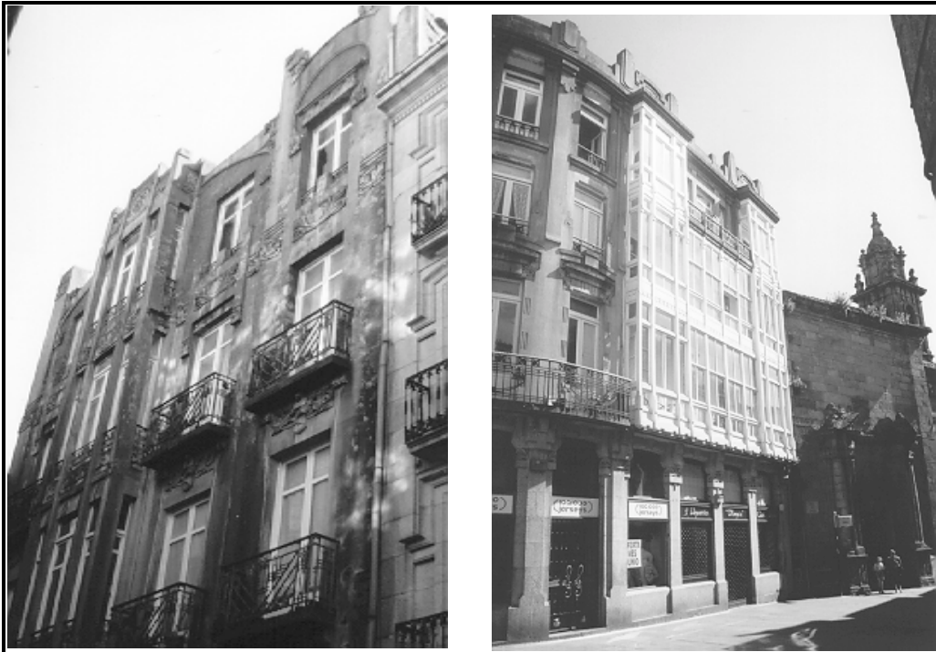
A esquerda o nº 6 da rúa do Preguntoiro e á dereita o nº 1 da rúa das Orfas (casa Gamayo), xunto á igrexa do mesmo nome. (Tipoloxía D).
