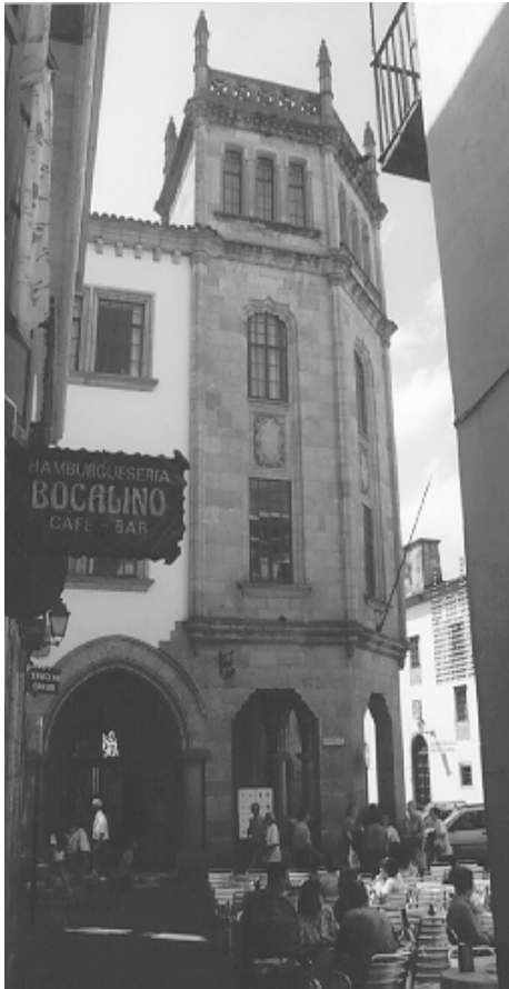
Casa nº 4 da rúa do Franco. (Tipoloxía B).
