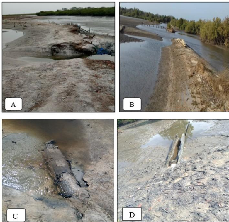
Photo 1 : Digues de protection dégradées à Niomoune (A) et à Diogué (B) et Buses en tronc de palmier abîmées à Haere (C) et à Hitou (D)
