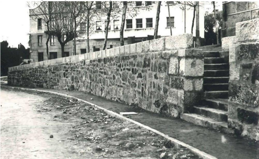
Figura 83. Obras de urbanización do Ramal dos Galos rematadas no ano 1963. Pódese observar na esquina superior dereita que aínda existía a edificación do mercado
