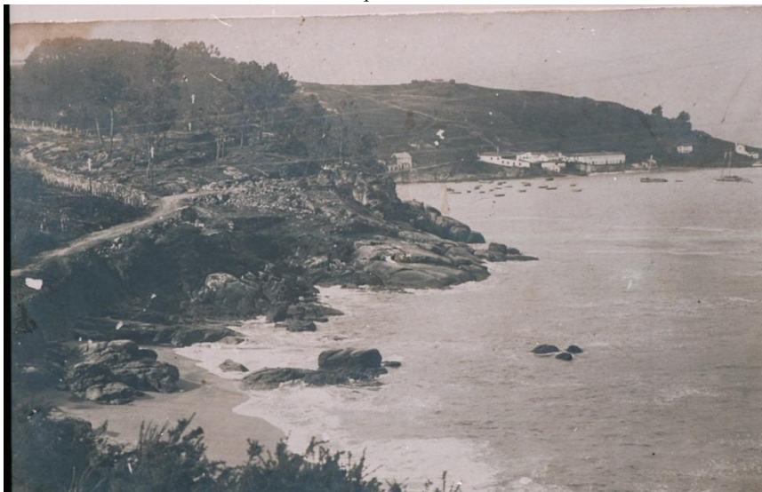
Figura 55. As canteiras da Robaleira que serían empregadas para a construción do dique leste
