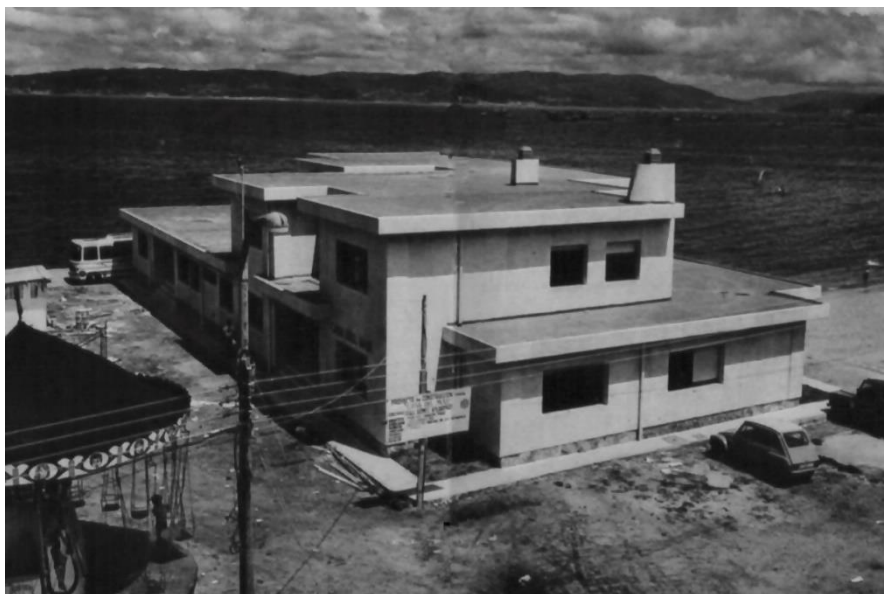
Figura 205. A Casa do Mar, en construción, nos anos setenta
