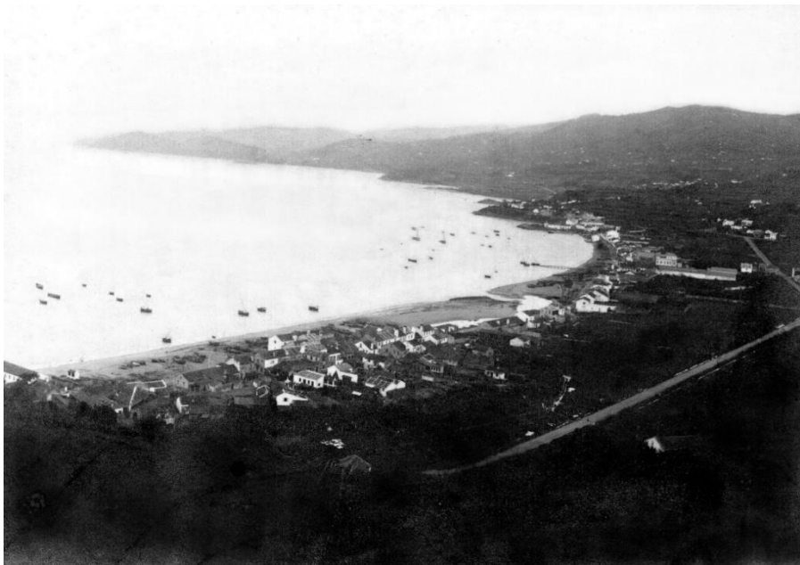
Figura 20. A Praia de Bueu a comezos do século XX. So existen os peiraos de madeira de Tapias e Massó, e apréciase a variable desembocadura do río, facendo unha lagoa. A zona máis densamente poboada sitúase na máis alá do río, na “banda” da ribeira
