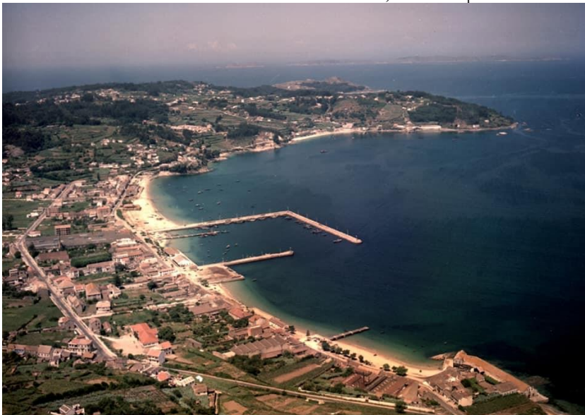
Figura 231. Os primeiros edificios en altura poden observarse na rúa H (Rosalía de Castro) e B (Johan Carballeira). Na parte central, abaixo, a fábrica de Attilio Gaggero, coa súa característica cuberta en dente serra, hoxe desaparecida
