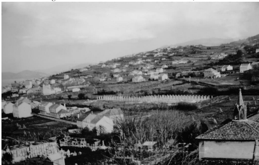
Figura 222. O colexio de A Pedra en construción, ca.1970
