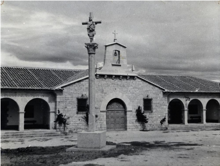
Figura 149. Fachada principal da capela-escola San Xosé que foi finalmente construída
