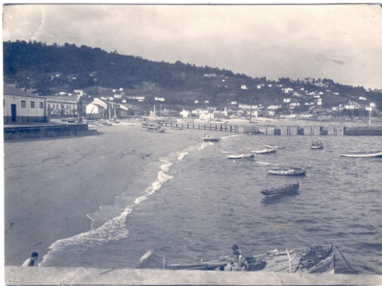
Figura 50. Peirao da fábrica Hermanos Massó ampliado con muros de cachotería, visto dende o porto de Bueu, ca. 1950. Xa desaparecera o primitivo peirao de madeira de La Perfección , e no seu lugar atopamos o recheo sobre o que se asenta o antigo edificio da praza municipal
