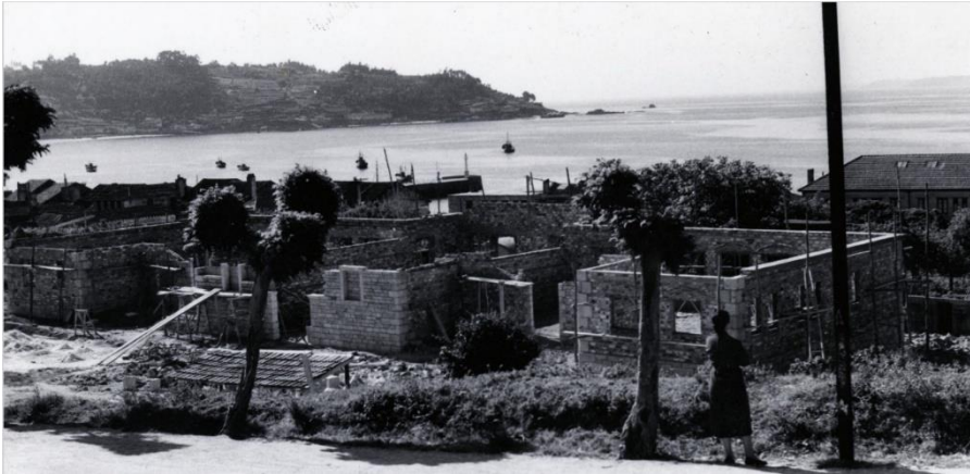
Figura 148. A capela-escola San Xosé en construción, ca. 1950. En primeiro plano, as árbores de Pazos Fontenla. Ao fondo vese o peirao da farola
