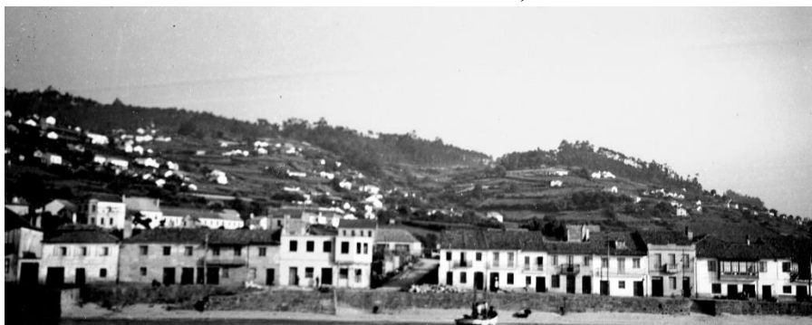
Figura 118. Montero Ríos e o seu cruce coa Rúa E (Matilde Bares), no centro da imaxe, na fronte marítima de Pescadoira, ca 1959
