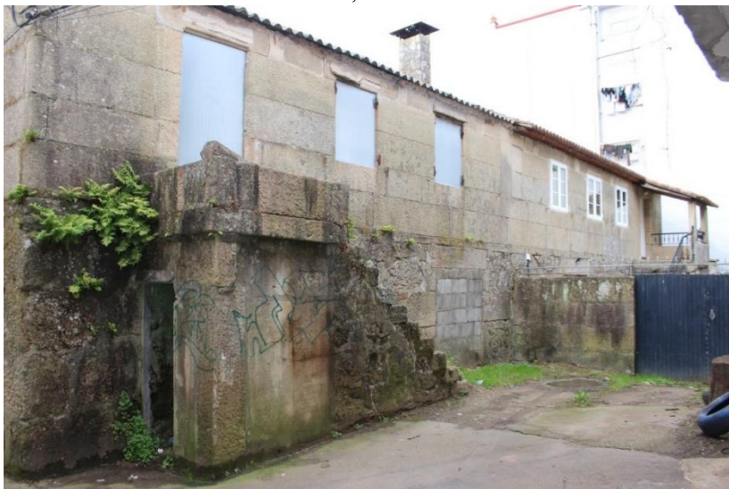
Figura 181. Sobreviventes edificacións con patín, na calella detrás de Montero Ríos nº91, en 2025
