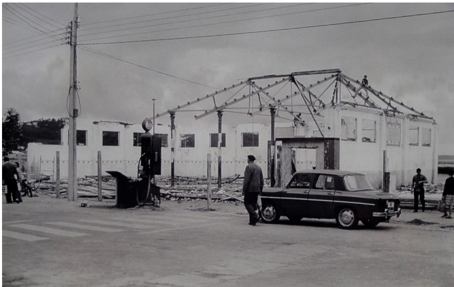
Figura 199. Desmontado Praza de Abastos vella ca. 1970
