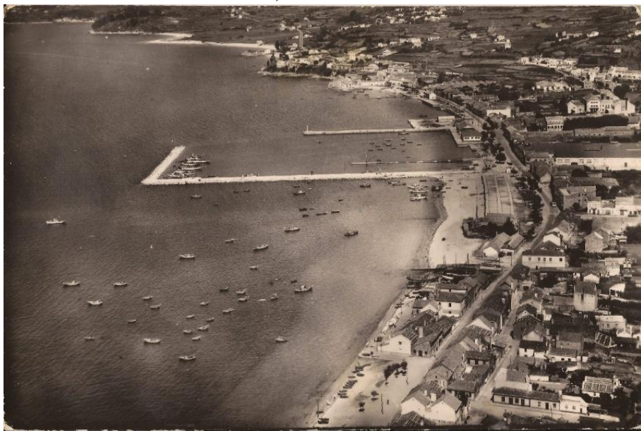
Figura 191. Bueu en 1963, o dique-molle xa está construído, séguelle o peirao da fábrica Hermanos Massó, o peirao da Farola e, en Pescadoira, o peirao de Attilio Gaggero. Na Banda do Río, pódese ver os piares da ampliación da carpintería de ribeira e, entrando no mar, o seu carro de varada
