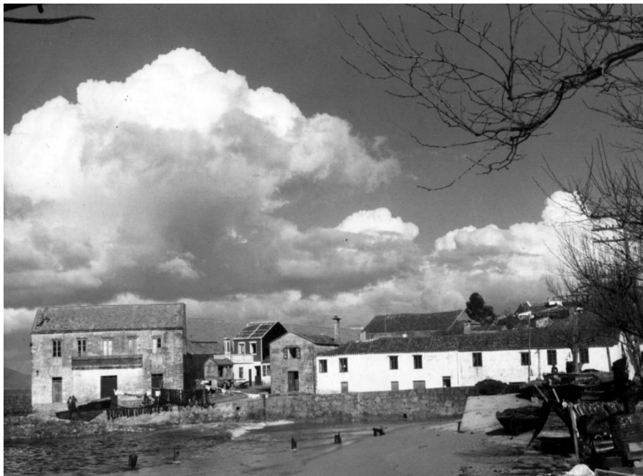
Figura 13. O antigo almacén A Obra no lugar de Pescadoira cara finais dos anos 1940, en estado de abandono. Redes e roupa a secar. Do primitivo peirao de madeira de Tapias so quedan os restos dos piares, e pódese observar a rampla
