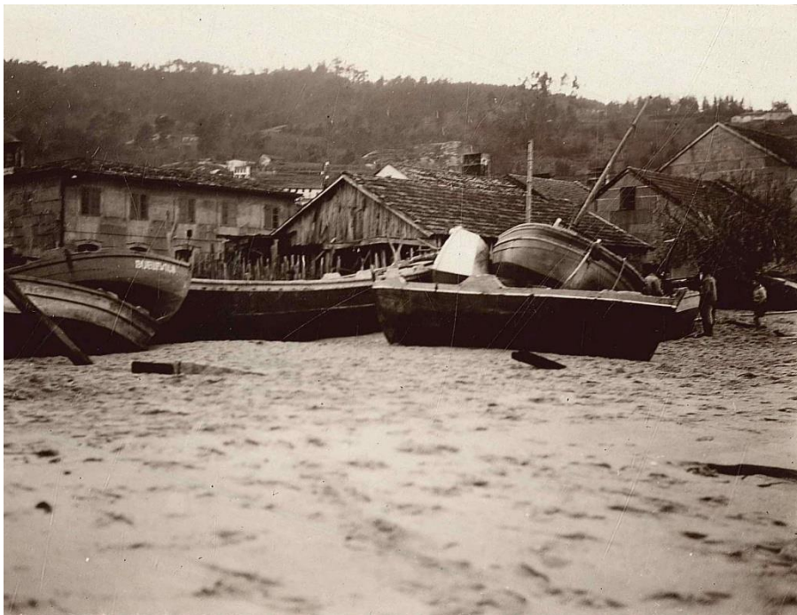
Figura 67. Volume inicial de carácter permanente da carpintería de ribeira da Banda do Río, con postes de pedra e tellado
